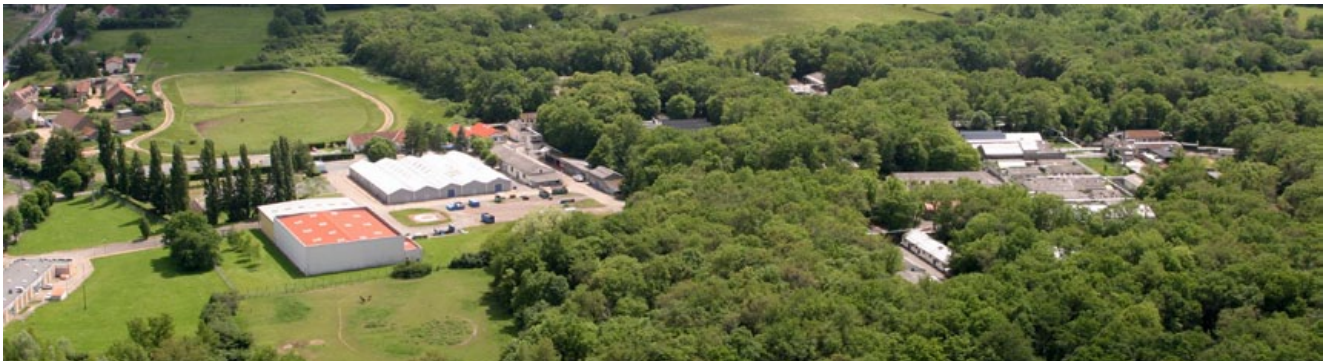
VICHY-FR-PS-AP02.JPG Vue aérienne du site Montpertuis / Semi aerial view of the Montpertuis site
