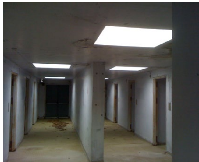
VICHY-FR-PS-P32.JPG Photographie intérieure du bâtiment n°53 Indoors photograph of the building 53
