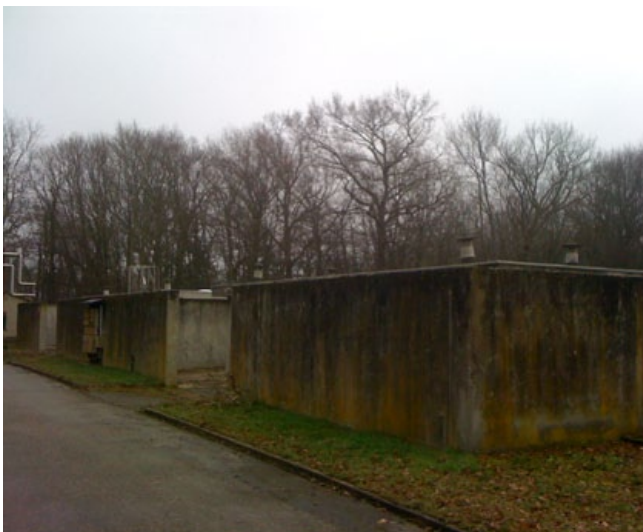
VICHY-FR-PS-P30.JPG Photographie extérieure du bâtiment n°53 Outside photograph of the building 53
